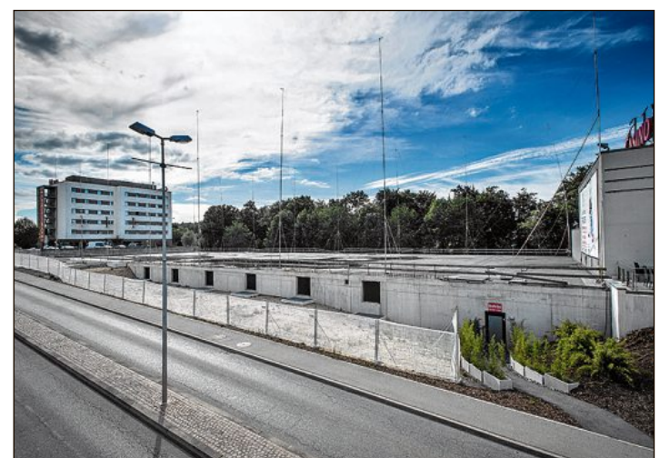
Le nouvel hôtel est prévu entre l'Ibis existant et le Casino Barrière.
